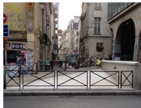
L'extrémité transformée de la trémie
