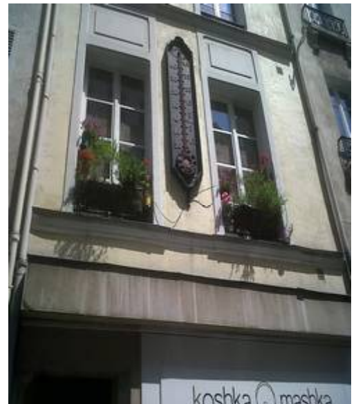
Le thermomètre a la taille des fenêtres!
