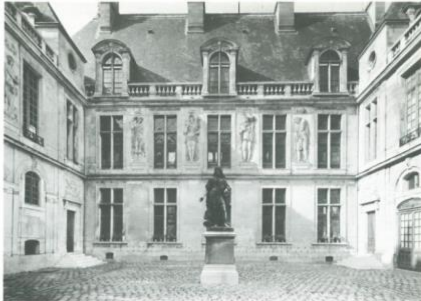
Hôtel de Ligneris (Carnavalet), rue de Sévigné, la cour, photographie Arch. Phot. Paris. Restauration hypothétique du Second Empire d'après une gravure de Moret, pour les lucarnes, la balustrade, les combles.
