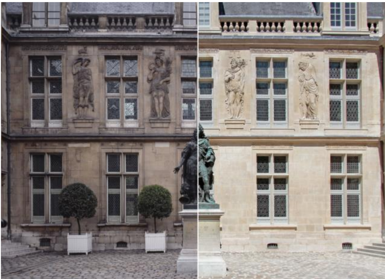
6 - Façade Ouest de la cour d'honneur avant et après restauration (2007 2015) © Jean-Baptiste Woloch / Gérard Leyris / musée Carnavalet
