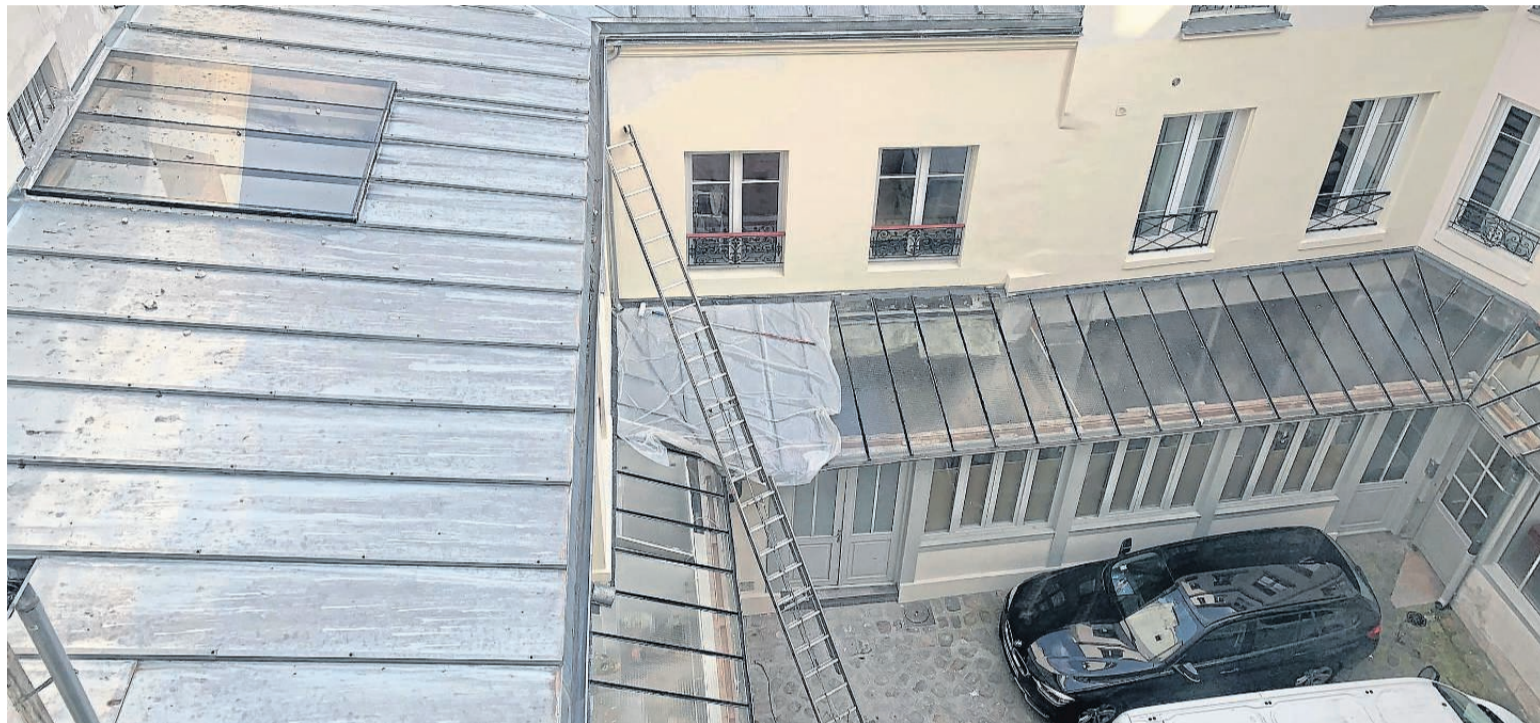
Au 20, rue des Gravilliers, à Paris (III e ), d'anciens locaux commerciaux avec une verrière protégée vont être transformés en logements dédiés à la location de courte durée.
